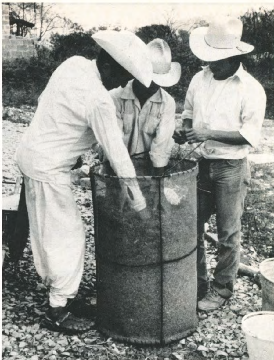
Figura 7. Pasteurización rústica del sustrato (paja de cebada), introduciéndolo en cilindros de malla para posteriormente sumergirlo en agua caliente a 70°C
